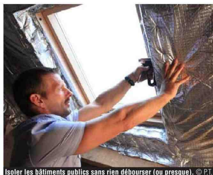
Isoler les bâtiments publics sans rien déboursier (ou presque). © P.T.
